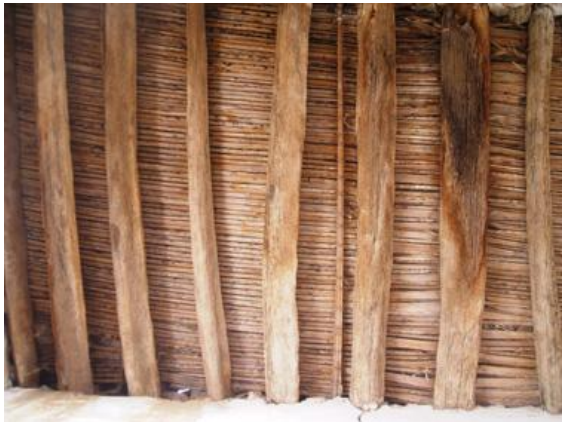
Figure 3.13: Vue de dessous d'une couverture avec tiges de palme, Biskra, Algérie (Haoui Samira)
