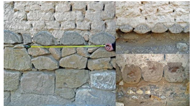
Figure 3.8: Mur mixte à assise en bois de palmier, variantes des dispositions, Biskra, Algérie (Haoui Samira)
