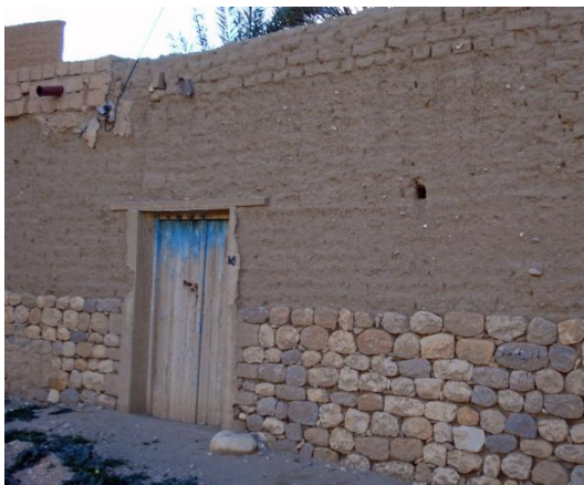
Figure 3.5: Façade d'habitation avec mur mixte, Biskra, Algérie (Haoui Samira)
