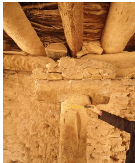
Figure 3.12: les éléments intermédiaires entre colonne en bois de palmier et couverture, Biskra, Algérie (Haoui Samira)
