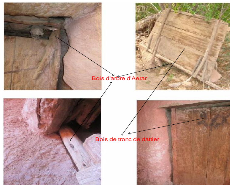
Figure 5: Portes en bois de tronc de dattier et d'Aerar (Ait Saadi, Remini, Farhi, 2015)
